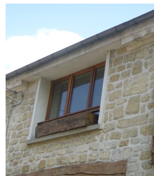
Altérations fréquentes : modification des proportions de la baie, adjonction de volets roulants, menuiseries PVC de taille non adaptée à la baie
