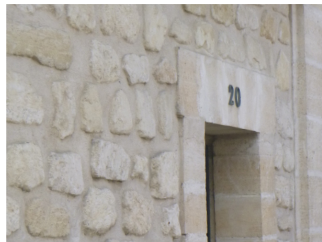
Altérations fréquentes : piochage des enduits, mise en œuvre d'enduits ciments
