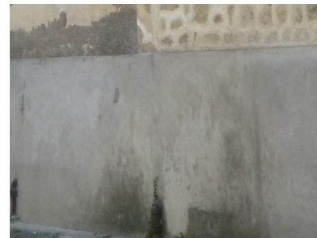
Altérations fréquentes : piochage des enduits, mise en œuvre d'enduits ciments
