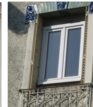
Altérations fréquentes : modification des proportions de la baie, adjonction de volets roulants, menuiseries PVC de taille non adaptée à la baie
