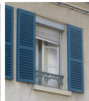
Altérations fréquentes : modification des proportions de la baie, adjonction de volets roulants, menuiseries PVC de taille non adaptée à la baie
