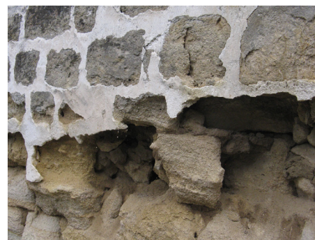
Altérations fréquentes : rejointoiement au ciment
