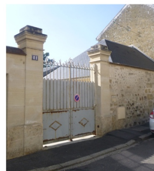
Exemples de différents portails anciens. La création d'une porte dans un vantail est une solution à envisager plutôt que le percement du mur de clôture pour ménager un portillon.
