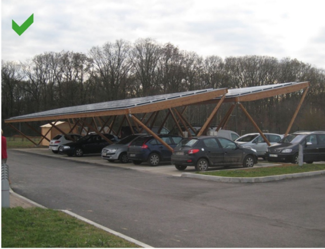
Exemples d'ombrières avec capteurs solaires avec structure portante en bois ou en métal
