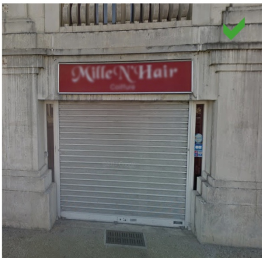
Le caisson du rideau métallique est implanté à l'intérieur
