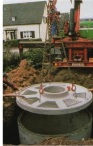
Installation d'une citerne enterrée
