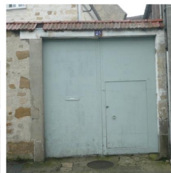
Exemples de différents portails anciens. La création d'une porte dans un vantail est une solution à envisager plutôt que le percement du mur de clôture pour ménager un portillon.
