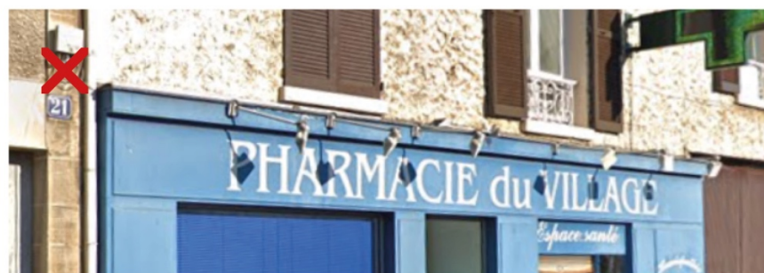
Système d'éclairage par projecteurs extérieurs posés en batterie
