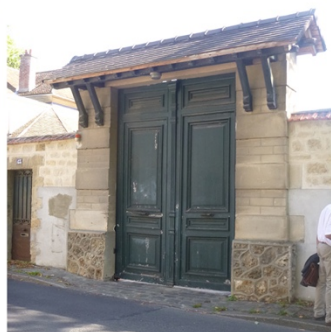
Exemples de différents portails anciens. La création d'une porte dans un vantail est une solution à envisager plutôt que le percement du mur de clôture pour ménager un portillon.
