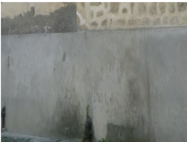
Altération fréquente : la mise en oeuvre d'enduits à base de ciment, peu respirants, entraîne des problèmes d'humidité dans les murs.
