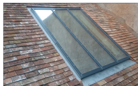
Exemple de verrières de type atelier pouvant être installées sur des toitures en tuile ou en ardoise.
