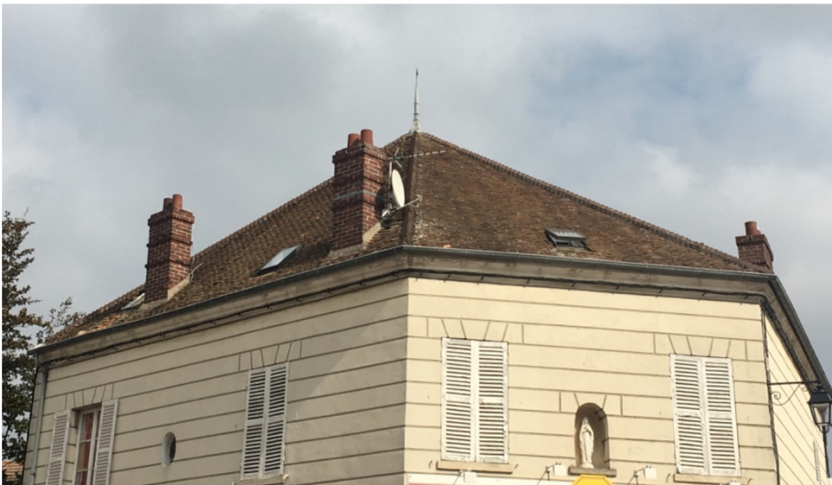
Différents exemples de toitures en tuile plates de petit moule
