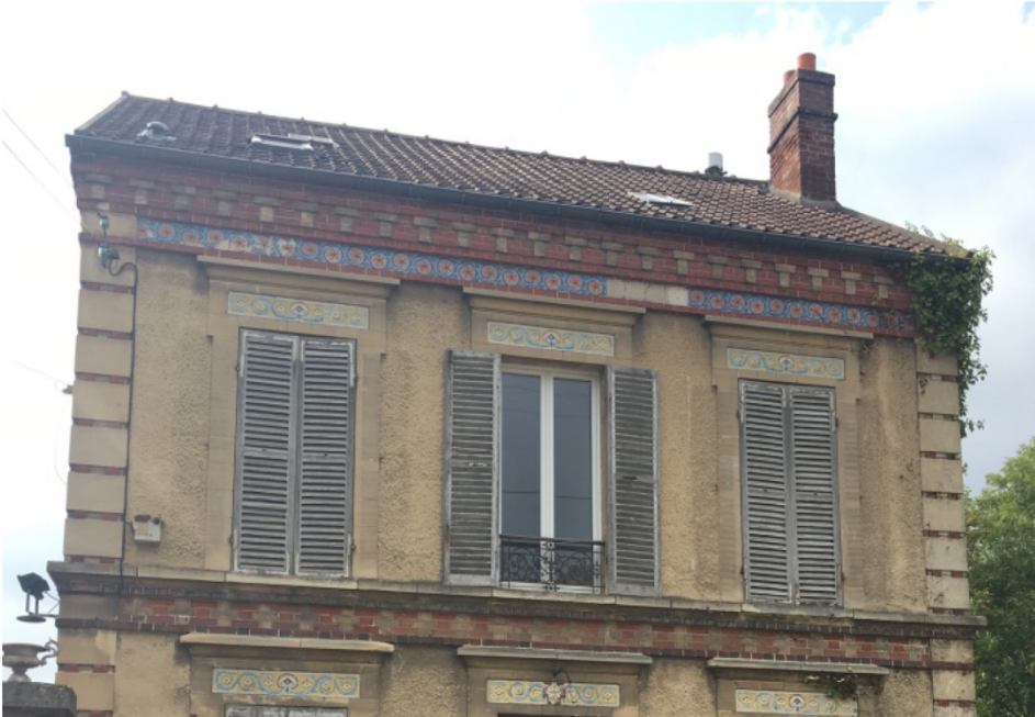
Exemple de façades mixtes associant pierre de taille, brique, enduit, meulière, etc.
