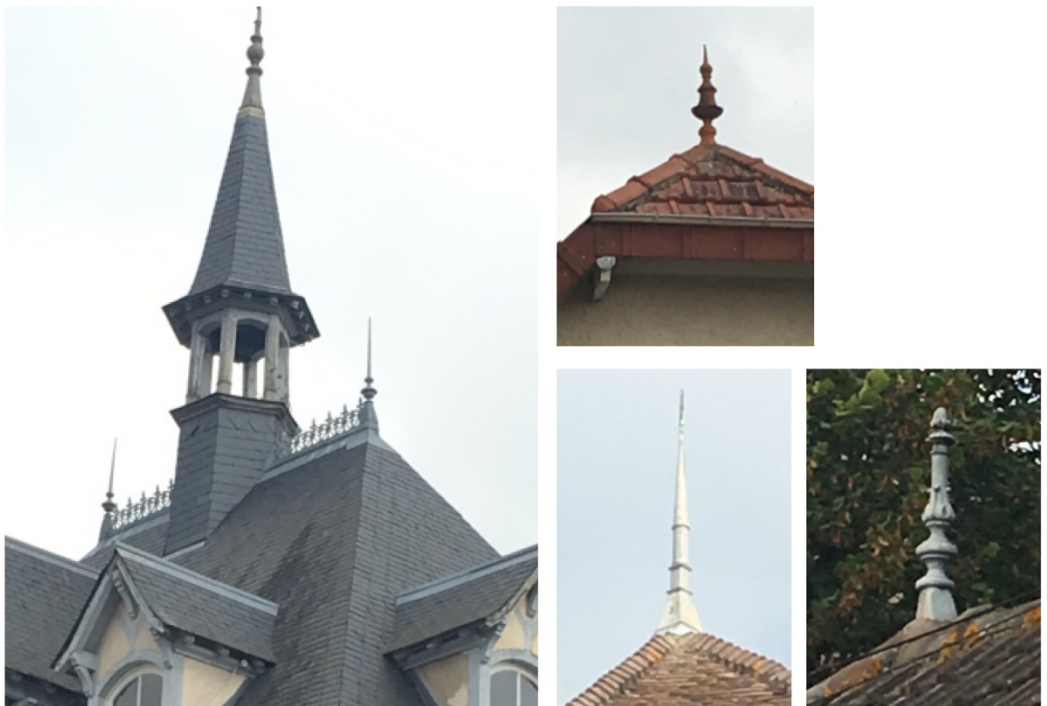
Exemples de décors de toiture : crête et épis de faîtage
