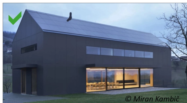
Exemples de panneaux de façade intégrant des panneaux solaires
