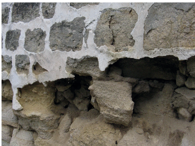
Altération fréquente : le rejointoiement au ciment de la pierre entraînant une alvéolisation de la pierre. L'eau se concentre dans la pierre et la fait éclater quand elle s'évapore. La pierre offre un aspect et un toucher sableux, sa structure étant comme décomposée.
