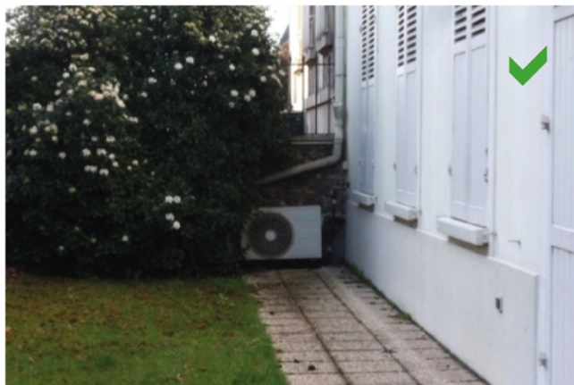
installation discrète pour une pompe à chaleur sur l'arrière d'une façade
