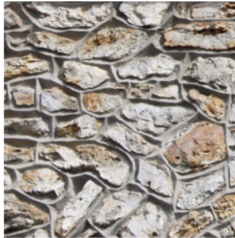
Exemples de façades en pierre meulière et détails de mise en œuvre : rocaillage et joints au ruban
