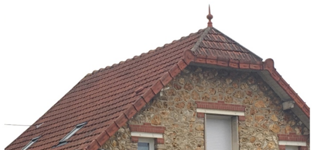
Toiture à demi croupe en tuile de terre cuite à emboîtement
