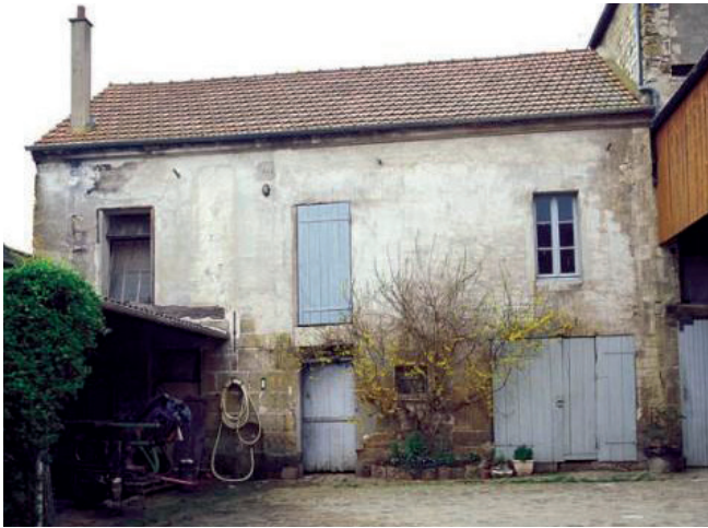
Bâti d'origine rurale présentant une façade en enduit lissé réalisé à base de plâtre et de chaux
