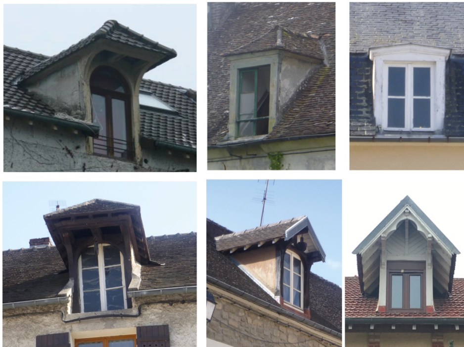
Différents exemples de lucarnes, en bois ou maçonnées.
