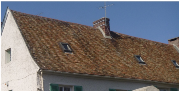
Toiture en bâtière en tuile plate de petit moule
