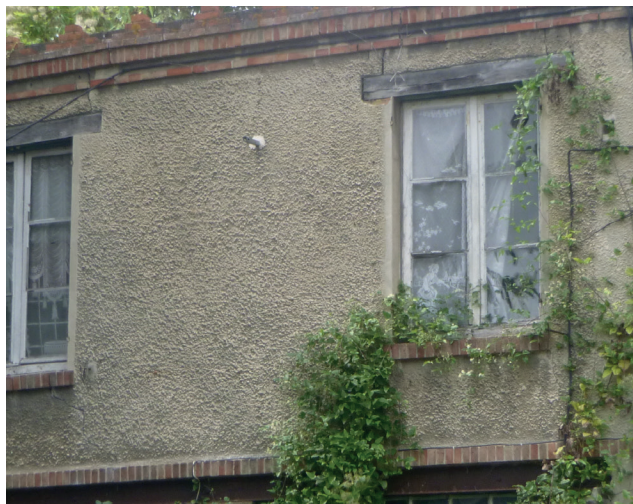
Façade en enduit projeté dit «tyrolien», finition courante de la fin du 19e siècle et jusqu'au milieu du 20e siècle.
