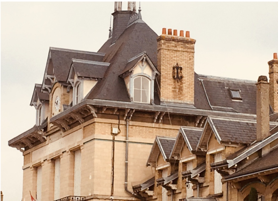
Différents exemples de toitures en ardoise
