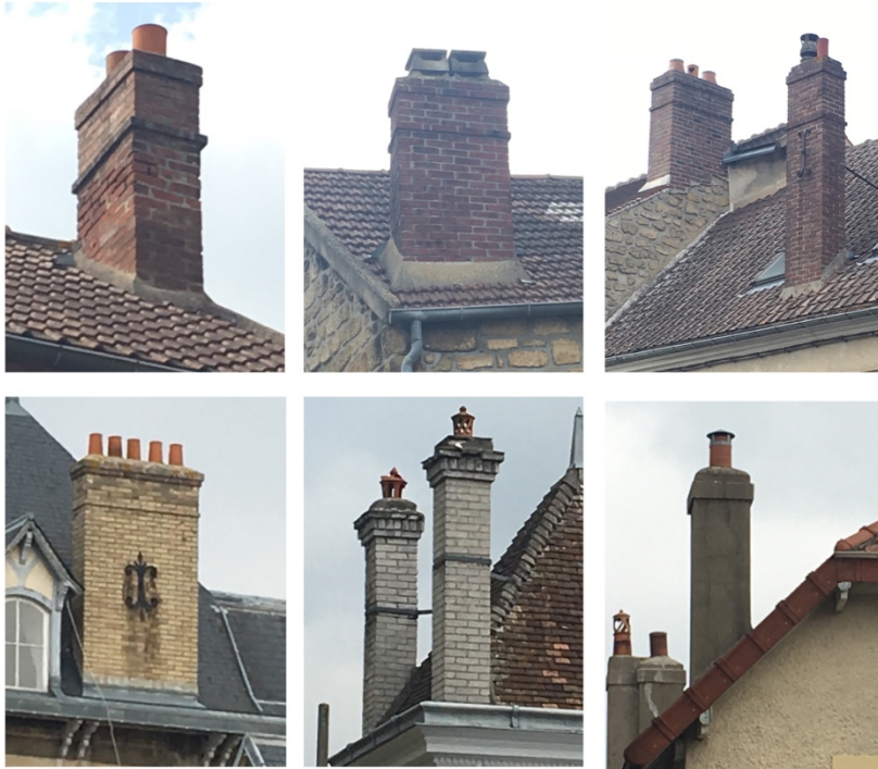
Exemples de conduits de cheminée principalement en brique, parfois enduits.
