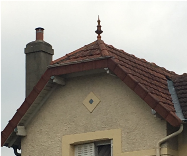
Différents exemples de toitures en tuile à emboîtement (aussi appelées tuiles mécaniques)
