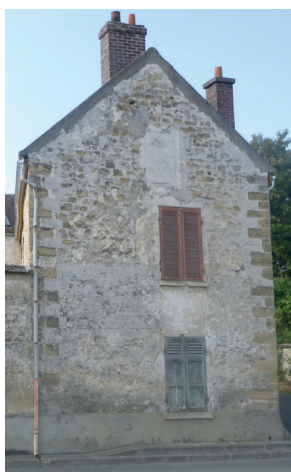
Association du moellon enduit et de la pierre de taille Éléments structurants (chaîne d'angle, piédroits, linteau...) Sont en pierre de taille
