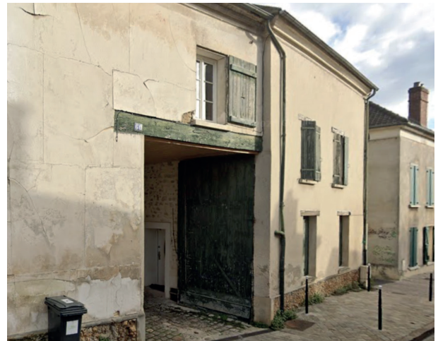
Bâti d'origine rurale présentant une façade en enduit lissé réalisé à base de plâtre et de chaux
