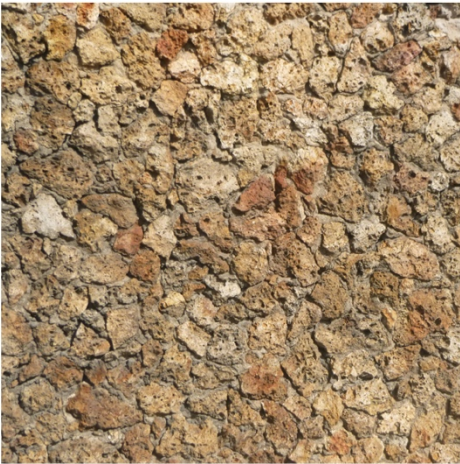
Exemples de façades en pierre meulière et détails de mise en œuvre : rocaillage et joints au ruban
