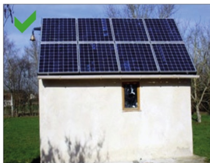
Exemples d'installation de panneau photovoltaïque et thermiques sur des appentis ou sur des structures indépendantes
