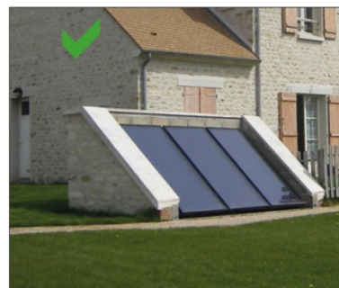
Exemples d'installation de panneau photovoltaïque et thermiques sur des appentis ou sur des structures indépendantes
