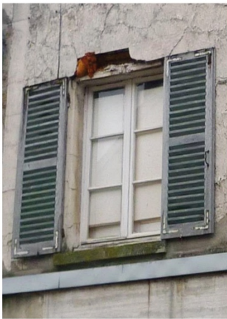
Menuiseries de fenêtre à 6 carreaux de la fin du 19 e s ou du début du 20 e s.
