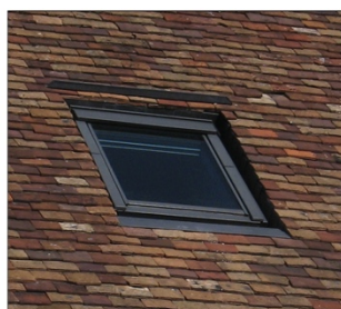
Exemples de fenêtres de toit présentant une pose encastrée dans des couvertures en tuile ou en ardoise : les chassis ne sont pas en saillie par rapport au plan de la toiture
