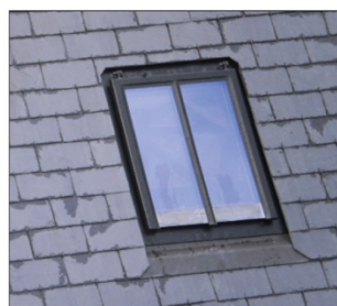
Exemples de fenêtres de toit présentant une pose encastrée dans des couvertures en tuile ou en ardoise : les chassis ne sont pas en saillie par rapport au plan de la toiture
