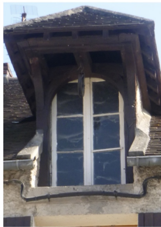
Menuiseries de fenêtre à 6 carreaux de la fin du 19 e s ou du début du 20 e s.
