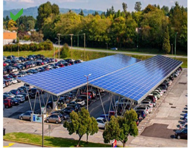
Exemples d'ombrières avec capteurs solaires avec structure portante en bois ou en métal
