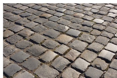
PAVÉ + JOINTS DE TERRE ET CHAUX PERMÉABILITÉ = 30%
